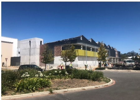
Nuwe Plaveisellaboratorium in aanbou.
