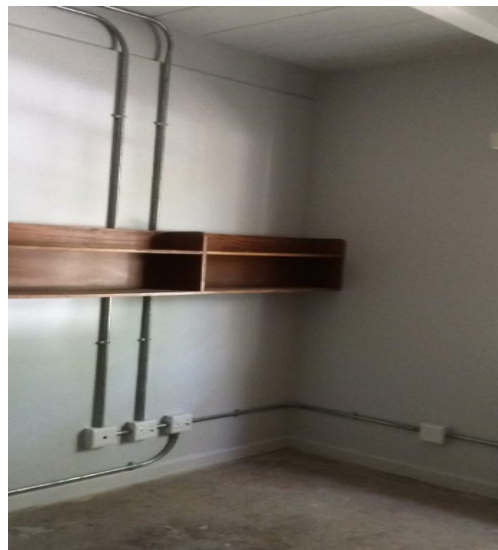
Nuwe elektriese en data-installasie in een van die kamers
