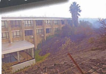
Hittete! Die brand het gelek-lek aan die Sportwetenskap-gebou. (Foto: Anton Jordaan, SSFD)
