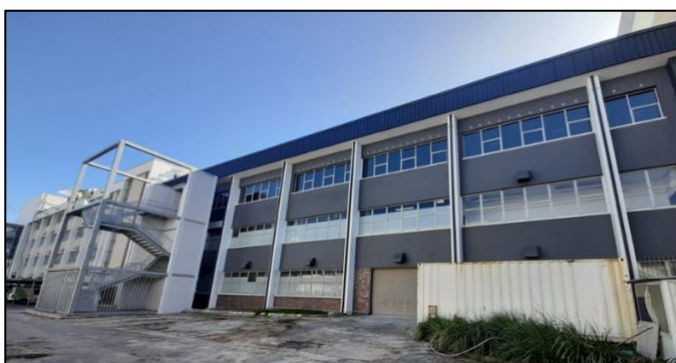
Nuwe tussenvloer op derde verdieping – suidelike aansig
