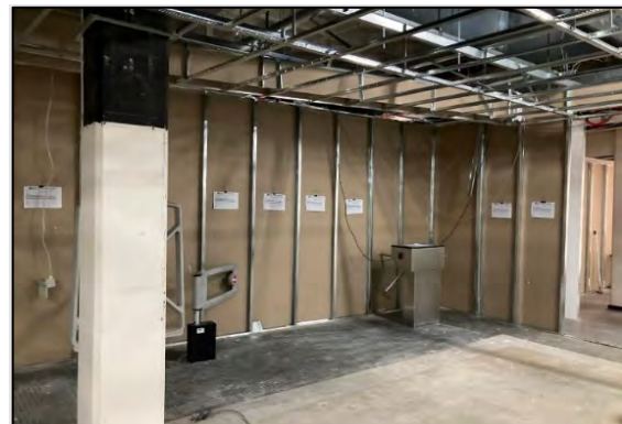
Figuur 56: Plafonraamwerk bo inligtingstoonbank-area
