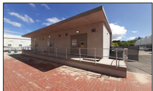
Figuur 32: Nuwe minisubstasie.
