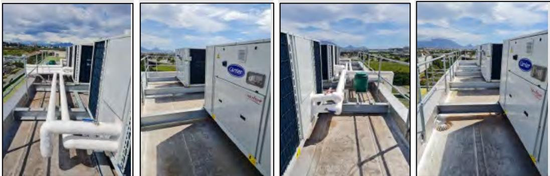
Figuur 83: Hippokrates-hittepompinstallasie
