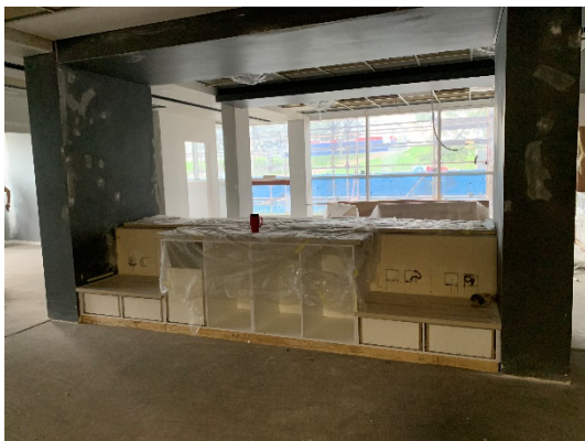
Figuur 53: Sone 1, verdieping 1: Interne skrynwerk – drukstasie.
