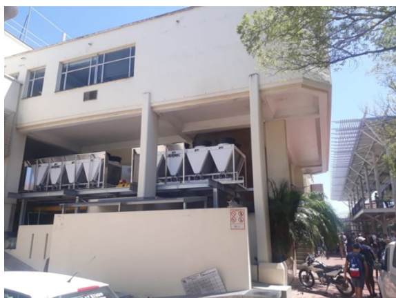
Figuur 39: Links: Die HVAC-gebiedsaanleg by die Neelsie is in gebruik geneem, en sal die Neelsie en die nuwe Jan Mouton Leersentrum bedien. Regs: Die eerste fase van die nuwe sentrale HVAC-gebiedsaanleg op Tygerbergkampus is voltooi. Hierdie nuwe aanleg sal ook die nuwe BMNI-gebou bedien.
