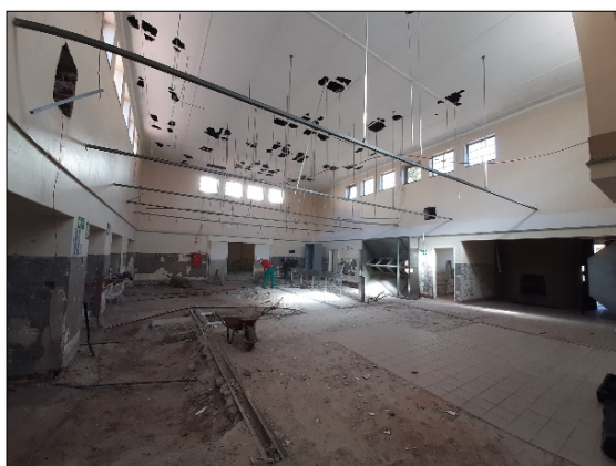
Figuur 68: Sloping en verwydering van betonvloer in kombuis.
