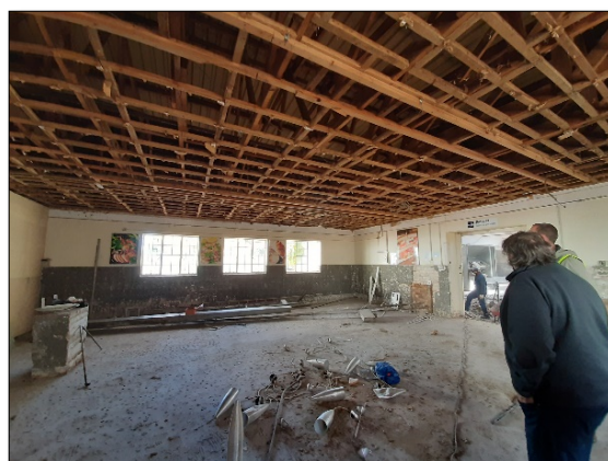
Figuur 69: Verwydering van ou plafonne in opskepparea.
