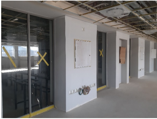
Figuur 57: Sone 1, verdieping 2: Installering van binnevensters en vinielvloere.
