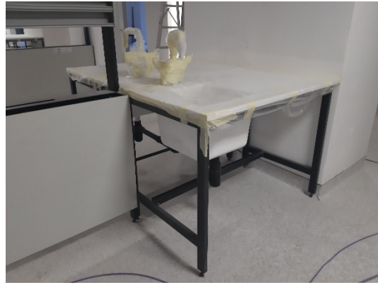
Figuur 58: Sone 1, verdieping 1: Installering van laboratoriumbanke en sanitêre ware.
