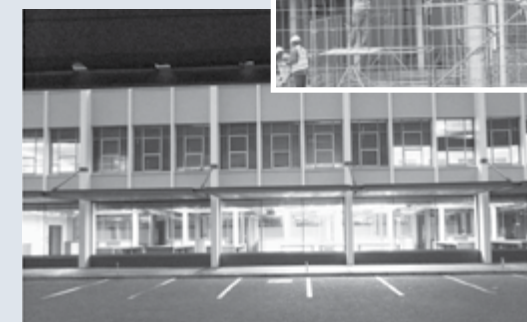
Die Studiesentrum in aanbou (bo) en nader voltooiing (onder).
