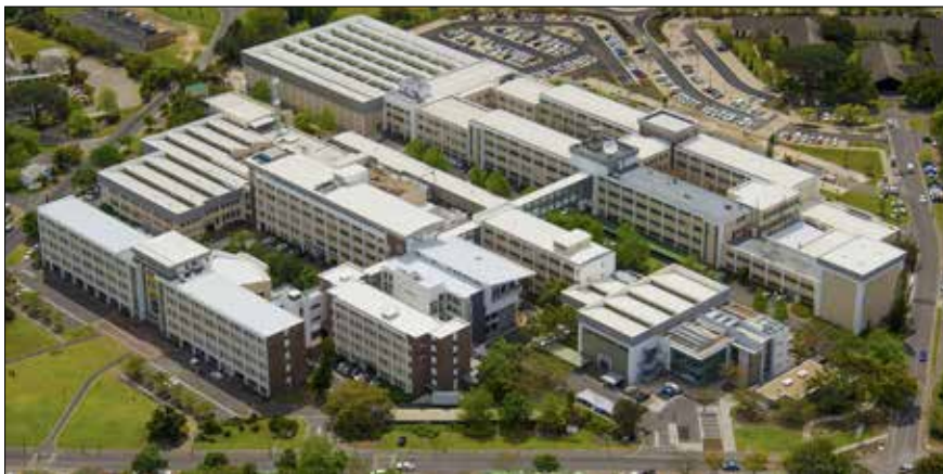
Die Ingenieurswese gebouekompleks, wat bykans 'n halfeeu oud is, gaan die volgende dekade omvangryke herinrigting, opknapping en verdigting ondergaan om op 'n meer kostedoeltreffende wyse vir meer studente en personeel voorsiening te maak.
